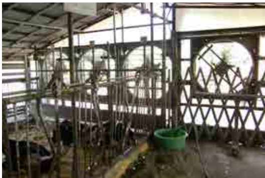
図6 トンネル換気による牛舎の暑熱対策
