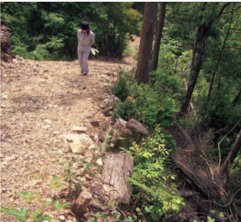
田辺林道の盛土法面（向かって右側の斜面）は緑化が早い
