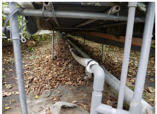
写真5 ベッド下部に配置された二酸化炭素施用ダクト
