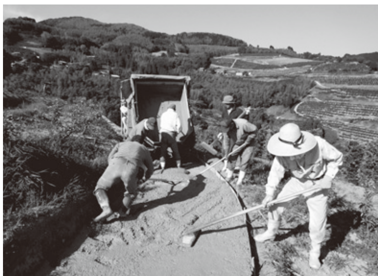
ミカン山に軽トラが上れるように、みんなで作業道をコンクリ舗装する 写真＝福岡県みやま市・佐井軒地区
