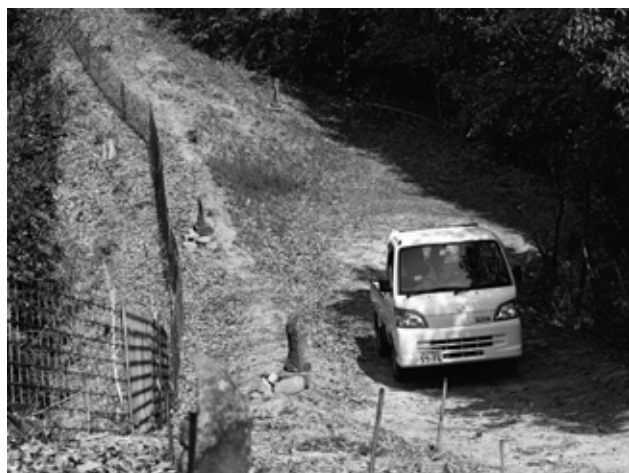
高さ1.3mの獣害柵に併設した「軽トラ道」のおかげで、 今では獣害ゼロを達成 写真＝大村嘉正
